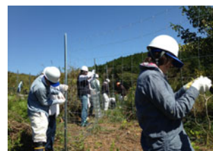
シカ防護柵の設置
